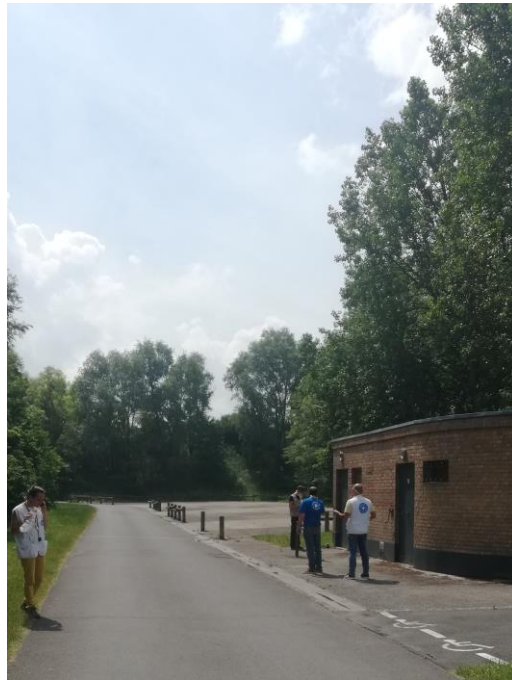
Bloc sanitaire existant (fermé) proche du parking de la base nautique
