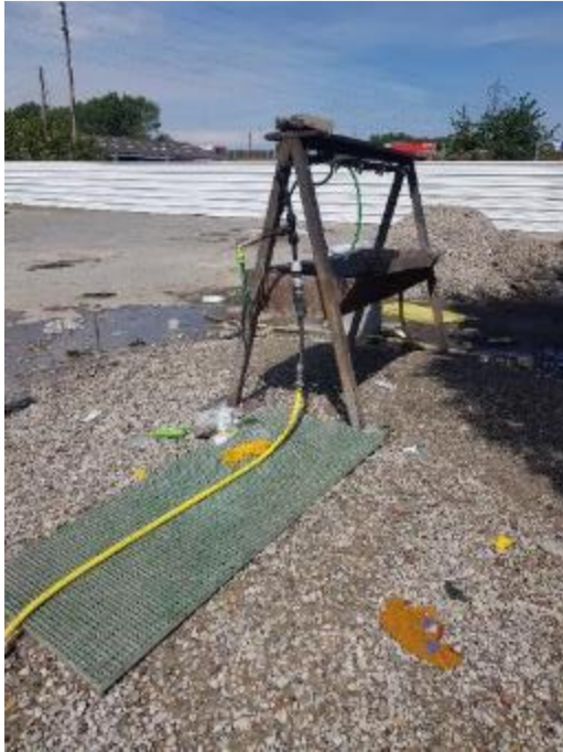
Point d'eau existant
